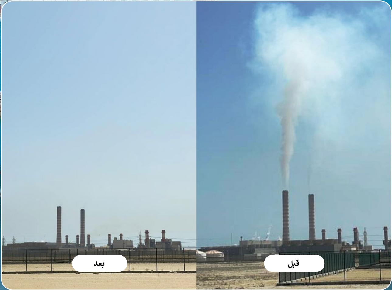
• البيئة المحيطة بمحطة الزور الجنوبية لتوليد الطاقة
