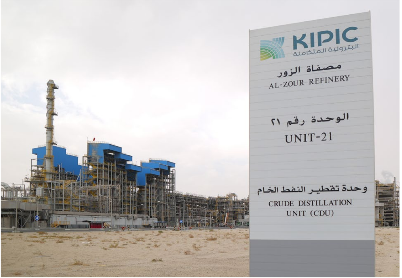
وحدة تقطير النفط الخام - الوحدة 21
