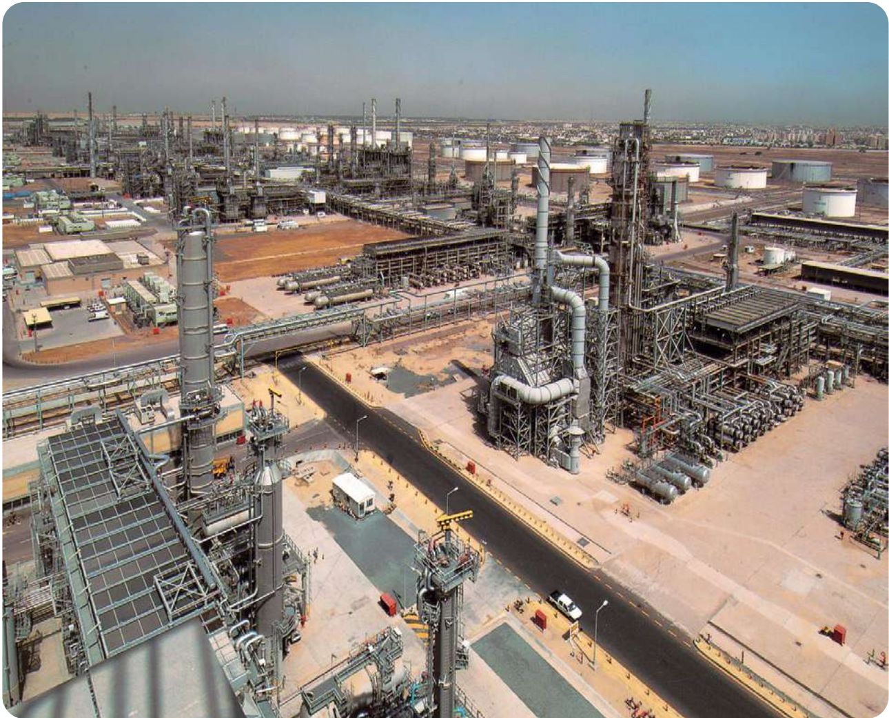
مصفاة ميناء الأحمدية بعد انتهاء عمليات الإصلاح
