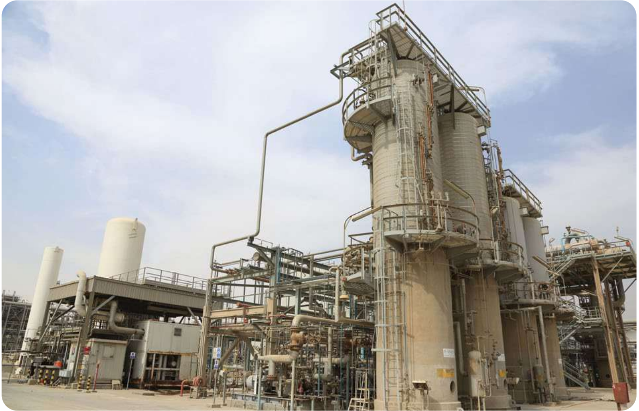
وحدة استرجاع غاز الشعلة بمصفاة ميناء الأحمدى
